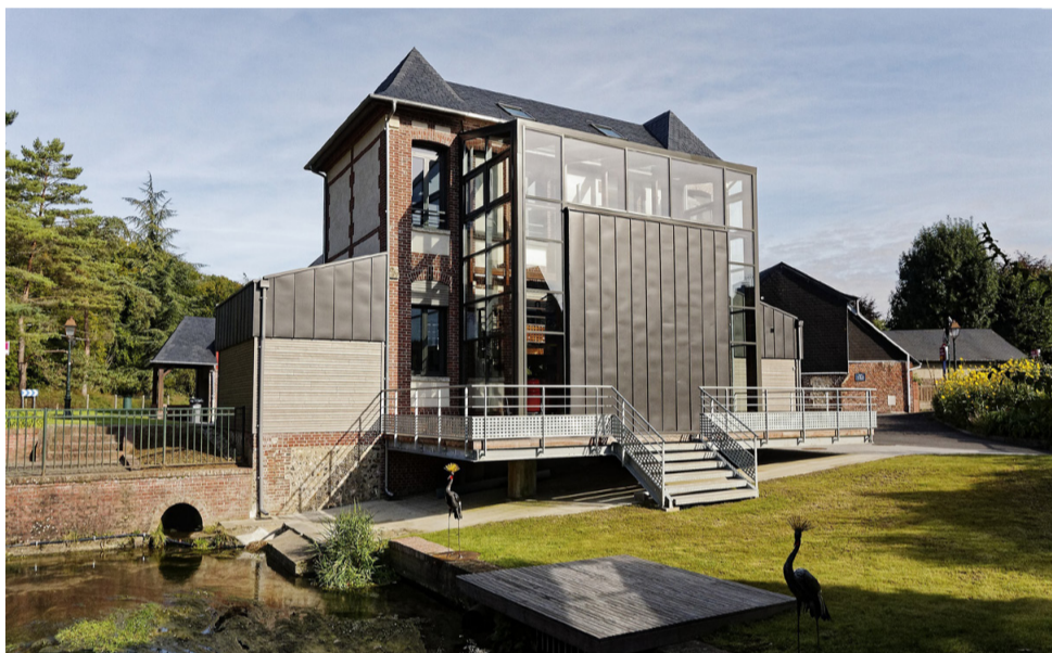
La cage d'escalier a été aménagée dans une structure vitrée. Le Bulletin
