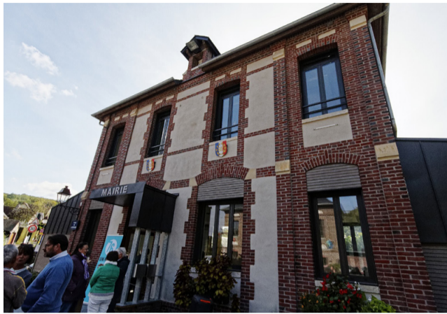
La mairie rénovée fera 75 % d'économie d'énergie. Le Bulletin
